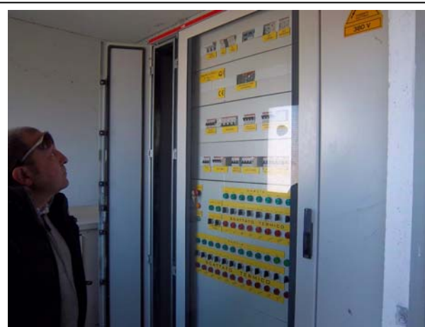
Figura 26 - Quadro elettrico generale
