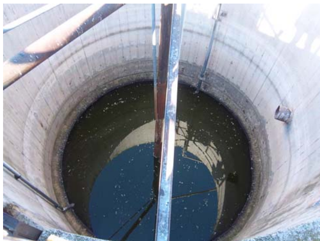
Figura 6 – Dissabbiatore disoleatore (air lift)
