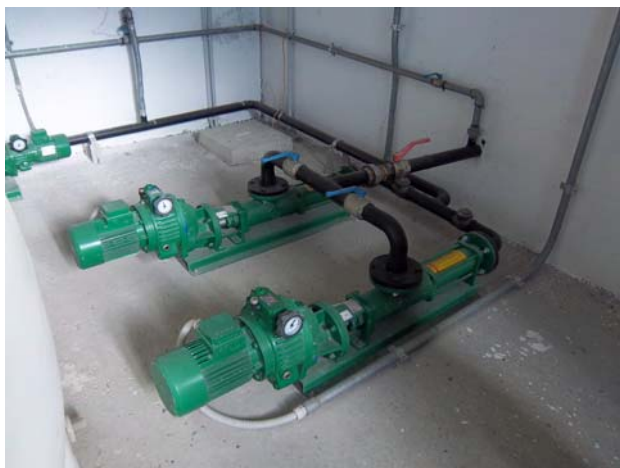
Figura 22 - Locale Disidratazione fanghi (particolare pompe monoviti)
