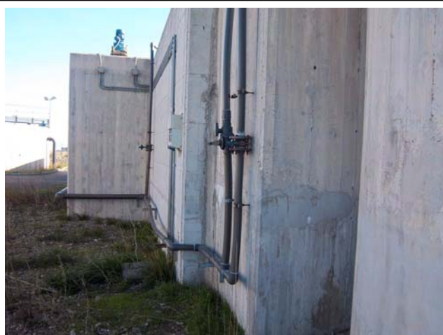
Figura 10 - Accumulo equalizzazione (tubazioni alimentazione e scarico aria)
