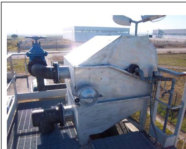
Figura 5 - grigliatura fine
