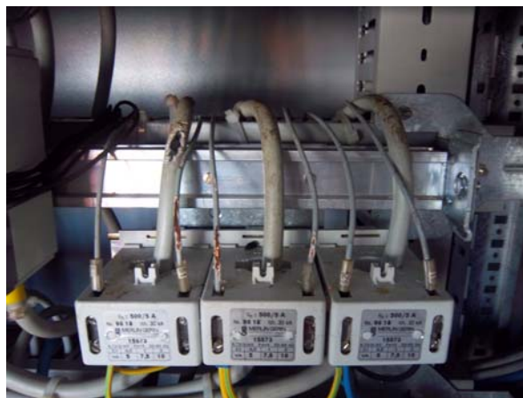
Figura 28 - Particolare dei cavi da sostituire
