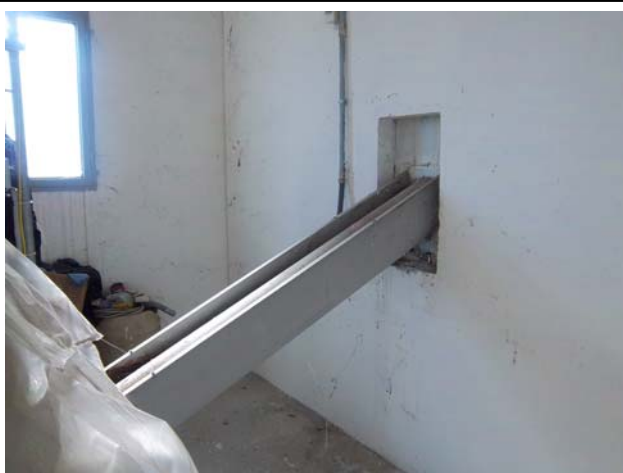
Figura 21 - Locale Disidratazione fanghi (particolare coclea)
