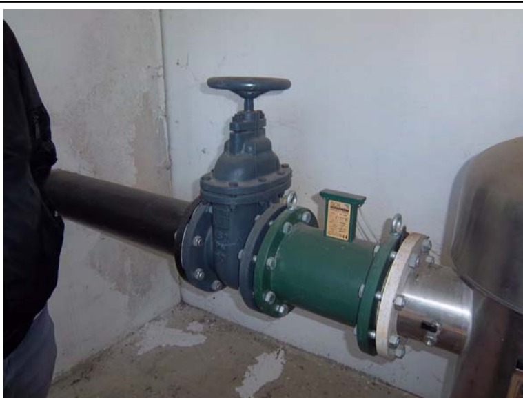
Figura 25 - Misuratore di portata
