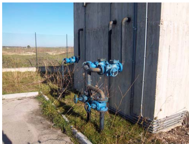
Figura 16 - Sedimentazione secondario (organi di manovra)
