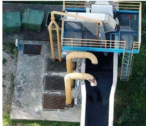
La stazione dedicata alla misura della portata in ingresso è realizzata in apposito canale pensile conformato con "Venturimetro" delle dimensioni 1,20 x (h)1,20 m per 20m di lunghezza di cui 12 m sono destinati alla misura della portata. La quota di fondo del canale è posta a +3,00 m dal p.c. ed il misuratore di livello è posto lateralmente al canale.
