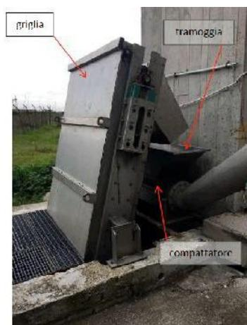
A valle della grigliatura fine (nella stazione di sollevamento di cui al punto successivo) vi è installato un impianto di sollevamento che convoglia i reflui ad una rotostacciatrice per la grigliatura fine. Da qui i reflui giungeranno al canale di misura. In alternativa alla grigliatura fine, i reflui verranno sollevati ed inviati ai successivi comparti.
